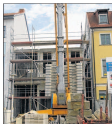
MIZ in Bergen: Die Decke im ersten Obergeschoss ist fertig. Foto: vw
